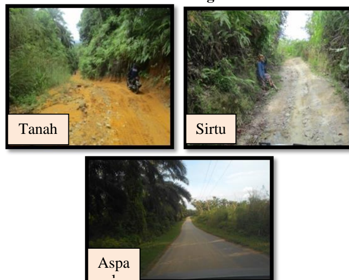
Gambar 3.10 Konstruksi Jaringan Jalan
