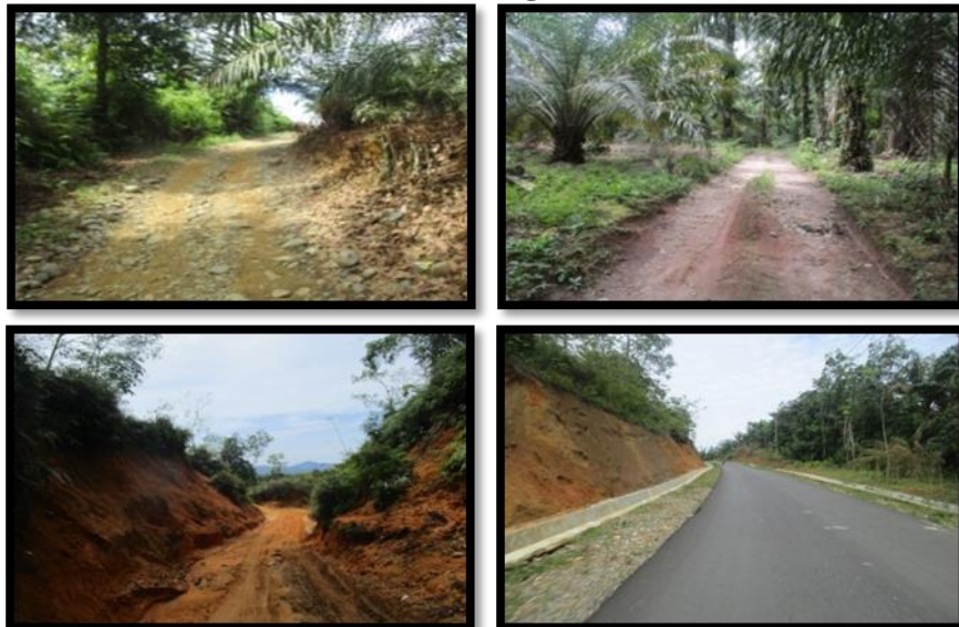
Gambar 3.11 Kondisi Jaringan Jalan
